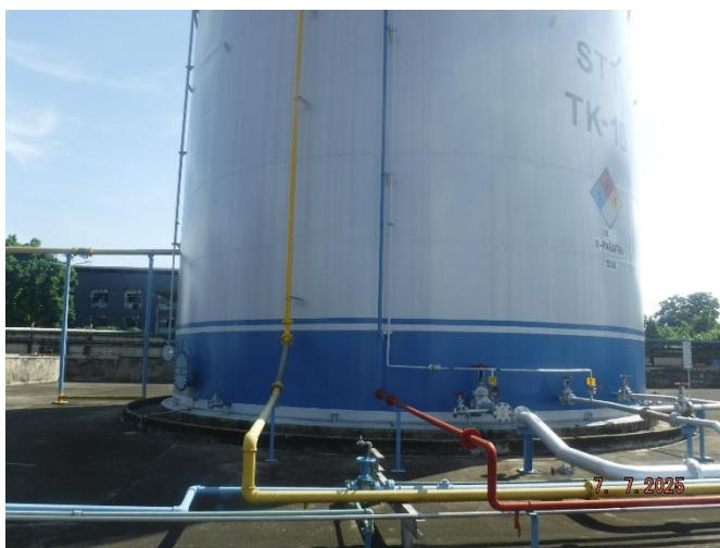
รูปที่ 2.2.1-5 Air Foam Chamber สีเหลือง, ระบบท่อดับเพลิงสีแดง(สีฟ้า)
