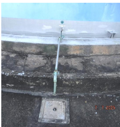
รูปที่ 2.2.1-7 สายดินของตัวถังถัง
