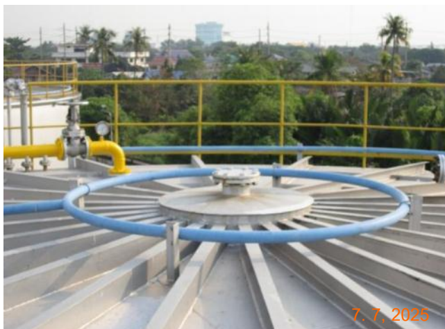
รูปที่ 2.2.1-6 ระบบท่ส่งน้ำหล่อเย็นบนถังเก็บ
