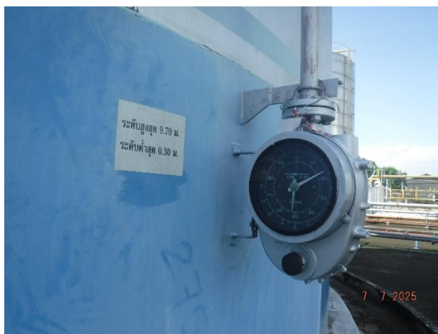
รูปที่ 2.2.1-2 Level Gauge
