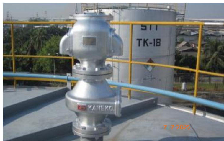
รูปที่ 2.2.1-1 Automatic Breather Valve
